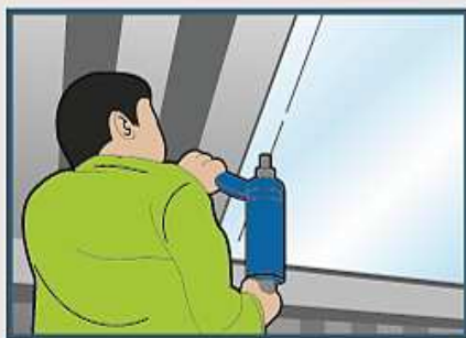
ใช้สว่านไฟฟ้า และตะปูเกลียวขนาด เบอร์ 10 ยาว 5/8 นิ้ว ชนิดเจาะเหล็ก หน้า 2.3 - 3.2 มม. พร้อม แหวนเจาะยึด Roof Batt ให้ติดกับจันทันทุกระยะ 30 ซม.
