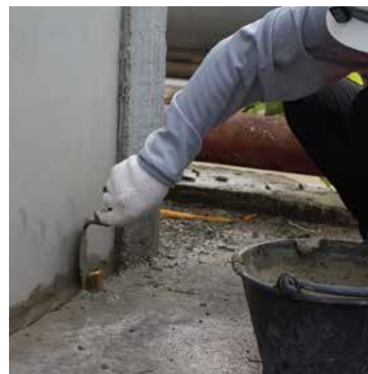
11. อุดด้านล่างของแผ่นผนัง Q-CON Groove Panel ด้วยปูนทราย
