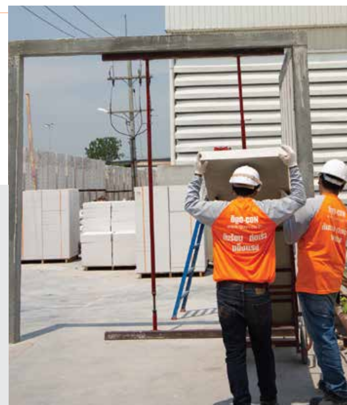
4. ยกแผ่นผนัง Q-CON Groove Panel เข้าติดกับข้างเสาโครงสร้าง
