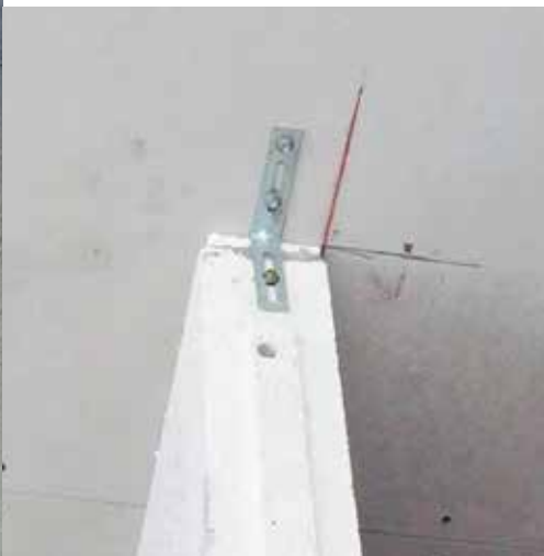
7. ยึดเหล็กฉากติดกับพื้นโครงสร้างด้วยพุกและยิงยึดสกรูเกลียวปลายสว่านเข้าด้านข้าง แผ่นผนัง Q-CON Groove Panel ทั้งด้านบนและล่าง
