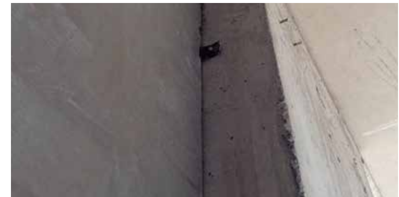
10. ติดตั้งแผ่นผนัง Q-CON Groove Panel แผ่นสุดท้าย เข้ากับโครงสร้างแล้วยึดติดด้วยพุก
