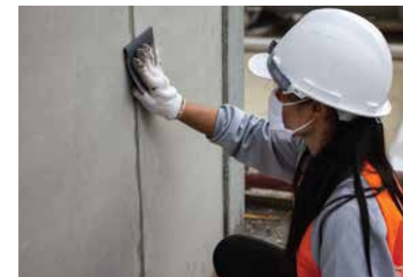
12. เก็บรอยต่อระหว่างแผ่นผนัง Q-CON Groove Panel ชั้นที่ 1 ด้วยปูนก่อ รอยแห้ง และขัดด้วยกระดาษทราย #400
