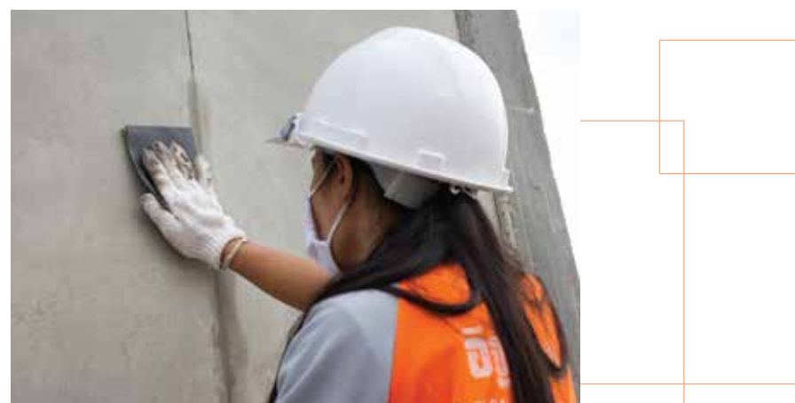
13. ชั้นที่ 2 ฉาบแต่งระหว่างรอยต่อแผ่นด้วย ปูน Skim coat และขัดด้วยกระดาษทราย #200
