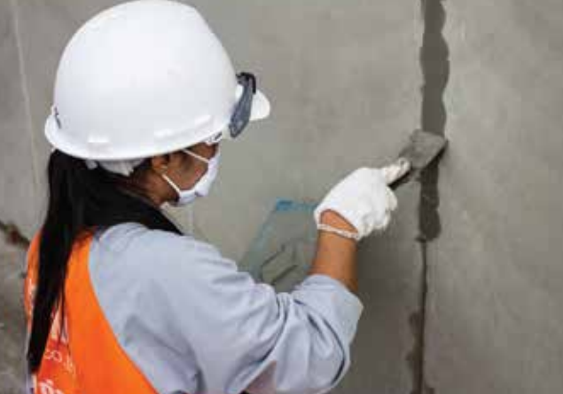
13. ชั้นที่ 2 ฉาบแต่งระหว่างรอยต่อแผ่นด้วย ปูน Skim coat และขัดด้วยกระดาษทราย #200
