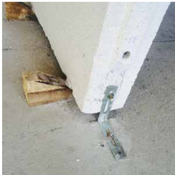
7. ยึดเหล็กฉากติดกับพื้นโครงสร้างด้วยพุกและยิงยึดสกรูเกลียวปลายสว่านเข้าด้านข้าง แผ่นผนัง Q-CON Groove Panel ทั้งด้านบนและล่าง
