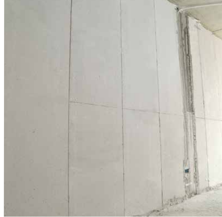
9. ติดตั้งแผ่นผนัง Q-CON Groove Panel ต่อๆ ไปจนถึง แผ่นสุดท้ายที่จะจบกับเสาโครงสร้าง
