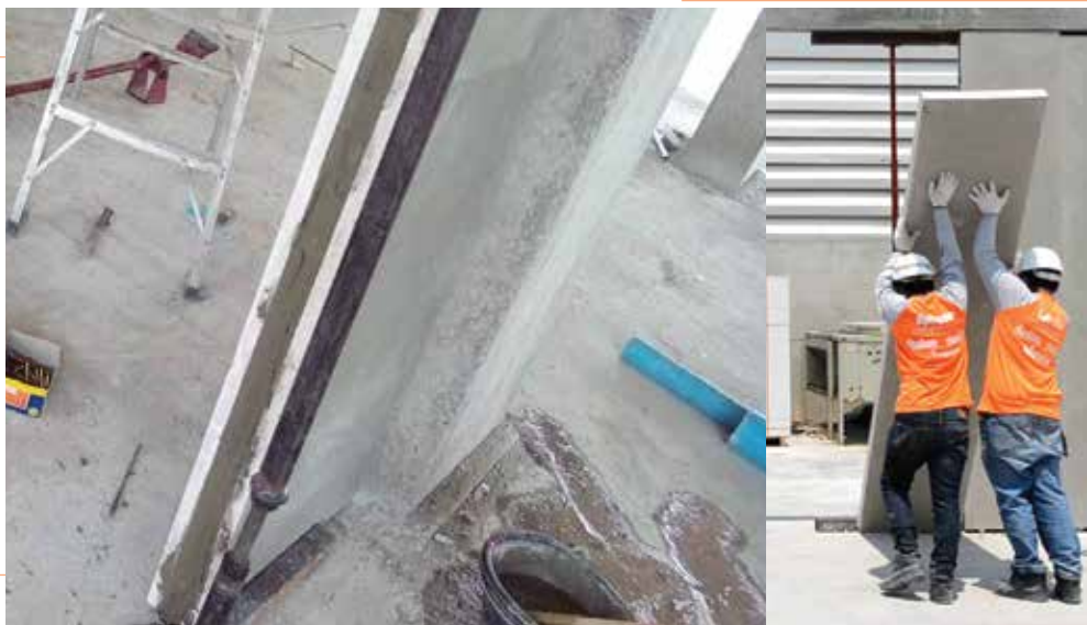
8. ป้ายปูนก่อ Q-CON ที่ข้างแผ่นผนัง Q-CON Groove Panel แผ่นที่ 1 และยก แผ่น Q-CON Groove Panel เข้าติดตั้งต่อไปแล้วทำเหมือนขั้นตอนติดตั้งแผ่นที่ 1
