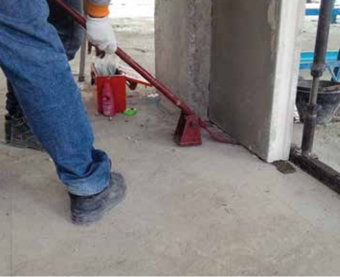
6. จัดแผ่นผนัง Q-CON Groove Panel จนชนกับพื้นโครงสร้าง ด้วยเหล็กจัดแผ่น แล้วสอดรองรับด้วยลิ้มไม้
