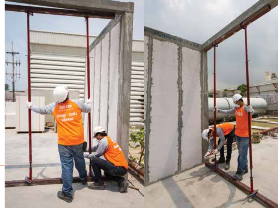
2. ติดตั้งชุดเหล็กเช็ดแนวผนัง
