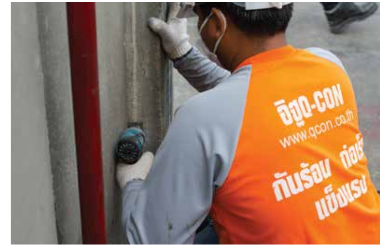
9. ติดตั้งแผ่นผนัง Q-CON Groove Panel ต่อๆ ไปจนถึง แผ่นสุดท้ายที่จะจบกับเสาโครงสร้าง
