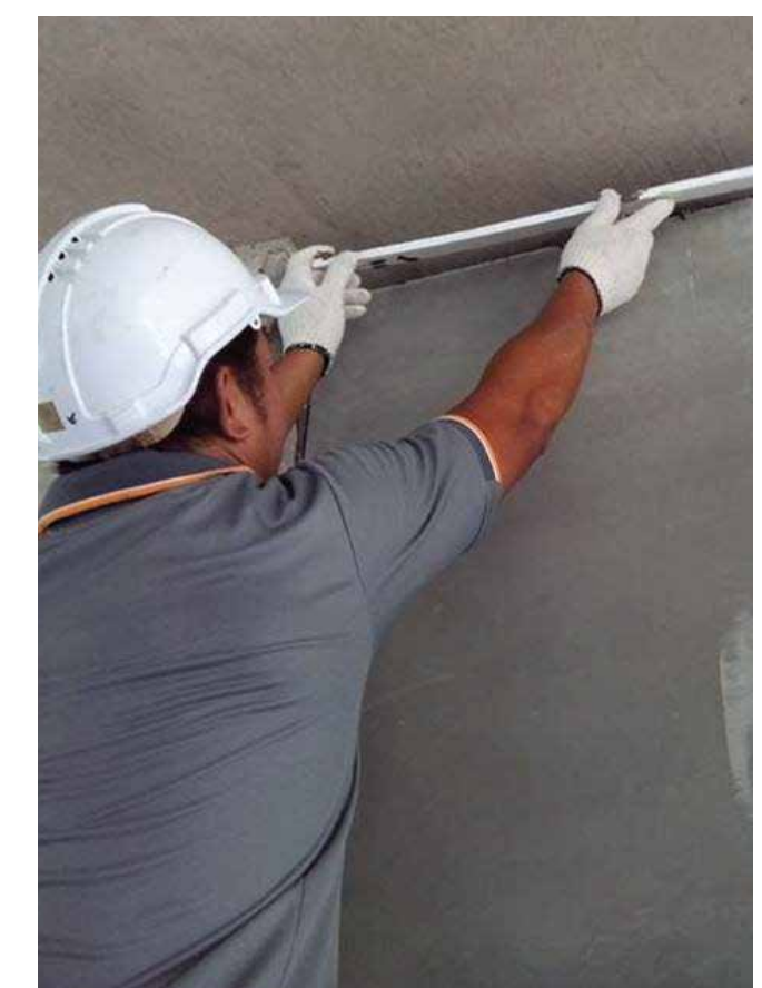
5. ติดแผ่นโฟมที่ได้ทอองพื้นโครงสร้างกับบนหัวแผ่นผนัง Q-CON Groove Panel
