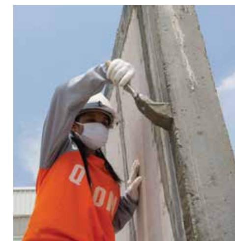
3. ป้ายปูนก่อก่อที่ข้างเสาโครงสร้าง
