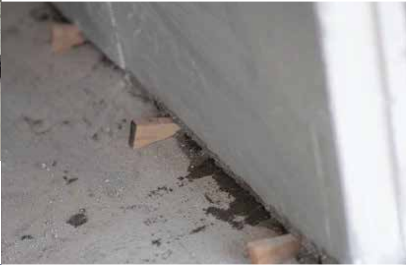
6. จัดแผ่นผนัง Q-CON Groove Panel จนชนกับพื้นโครงสร้าง ด้วยเหล็กจัดแผ่น แล้วสอดรองรับด้วยลิ้มไม้
