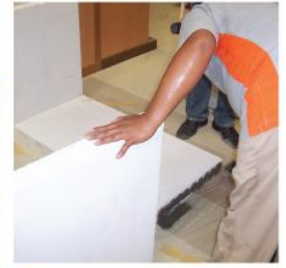
5) ป้ายปูนก่อ Q-CON ด้านข้างของแผ่นตัวล่าง (CF)
