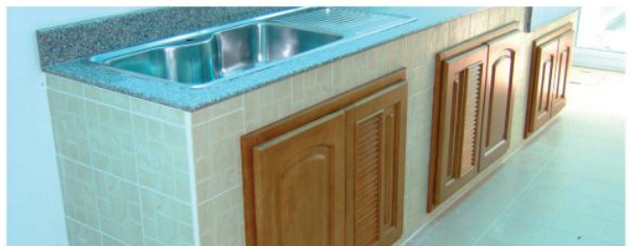
12) ติดตั้งชุดอุปกรณ์ต่างๆ เช่น กั้นแกรนิต Sink ชุดบาน Sink เป็นต้น
