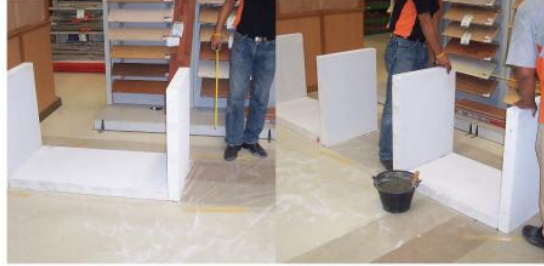
7) วางแผ่นขาตั้ง (CC) และตัวบน (CF)
