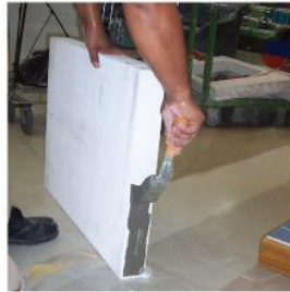
2) ป้ายปูนก่อ Q-CON ด้านข้างของแผ่นขาตั้ง (CC)
