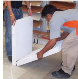
4) ยกแผ่นตัวล่าง (CF) วางติดกับแผ่นขาตั้ง
