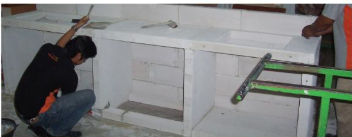
11) ก่ออิฐ Q-CON ปิดด้านหลัง และตกแต่งรอยต่อของ Counter
