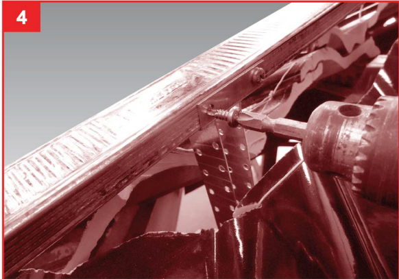
4 ยึดเหล็กรับกรอบติดกับชายยึดเหล็ก ด้วยตะปูเกลียวยึดแปจำนวน 4 ตัว โดยให้ระดับหลังของเหล็กรับกรอบสูงกว่าระดับหลังแปตามที่กำหนดไว้
