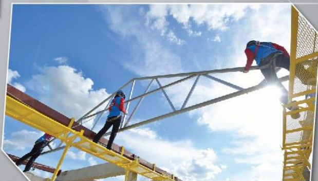
มีการใช้ Sky Walker ซึ่งออกแบบเฉพาะ SCG เพื่อความปลอดภัยในการทำงาน
