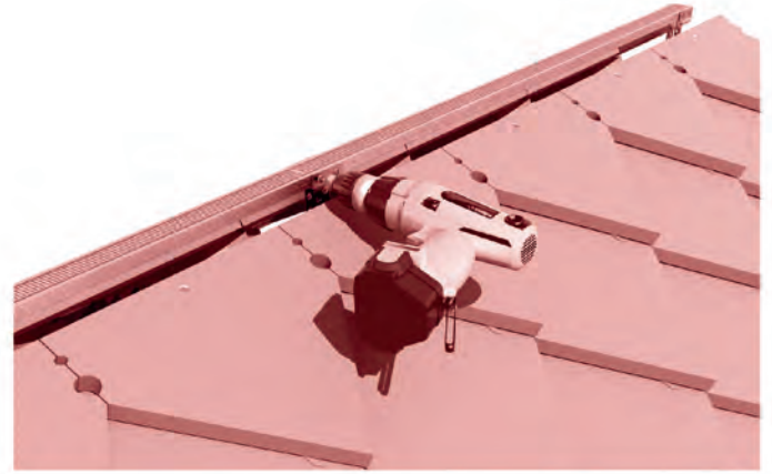
4. ยึดเหล็กรับครอบติดกับขายึดเหล็ก ด้วยตะปูเกลียวยึดแปจำนวน 4 ตัว โดยเหล็กรับครอบต้องอยู่ในระดับเดียวกัน และอยู่ในแนวกึ่งกลางสันหลังคา
