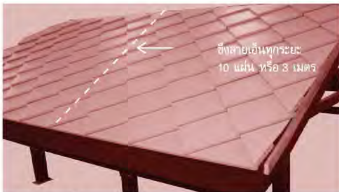
4. ติดตั้งกระเบื้องแถวถัดไปด้วยกระเบื้องผืนหลังคาโดยมุงจากล่างขึ้นบนและให้ปลายแหลมของกระเบื้องตรงกับมุมซ้อนทับด้านข้างระหว่างกระเบื้องแถวล่างทุกแผ่น และควรซิงสายเอ็นระหว่างเชิงชายกับสันหลังคา เพื่อบังคับแนวของกระเบื้องให้ตรงทุกกระเบื้อง 10 แผ่น หรือ 3 เมตร และทำการยึดกระเบื้องผืนหลังคาด้วยตะปูเกลียวยึดกระเบื้องปลายสว่าน เอสซีจี 1.5 นิ้ว แผ่นละ 2 ตัว ควรยึดกระเบื้องทุกแถวทุกแผ่น
