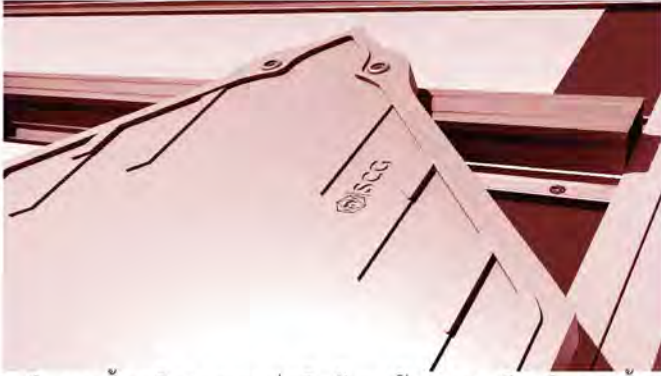
2. ยึดกระเบื้องเชิงชายทุกแผ่นติดกับแปด้วยตะปูเกลียวยึดกระเบื้อง ปลายสว่าน เอสซีจี 1.5 นิ้ว โดยยึดแผ่นละ 2 ตัว
