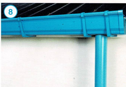
8. หลังจากการติดตั้งเสร็จ ควรทดสอบการระบายน้ำ พร้อมทั้งเช็ดทำความสะอาด ด้วยน้ำสบู่ หรือน้ำยาล้างจาน
