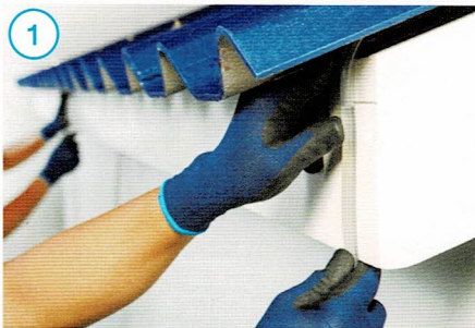
1. หาระดับบนเชิงชายเพื่อทำการติดตั้งรางน้ำฝน โดยใช้สายยางวัดระดับน้ำ
