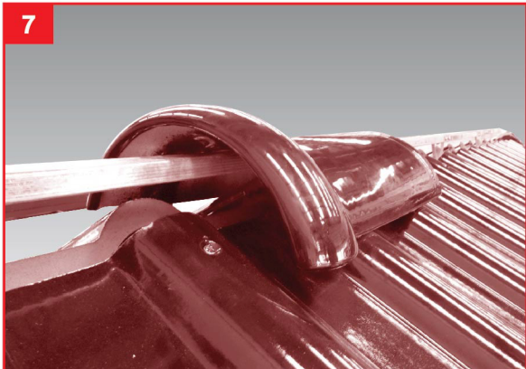
7 นำครอบหลังคามาวางเพื่อตรวจสอบระยะแผ่นรองใต้ครอบ เมื่อรีดแล้วต้องไม่เกินขอบของครอบหลังคาออกมา
